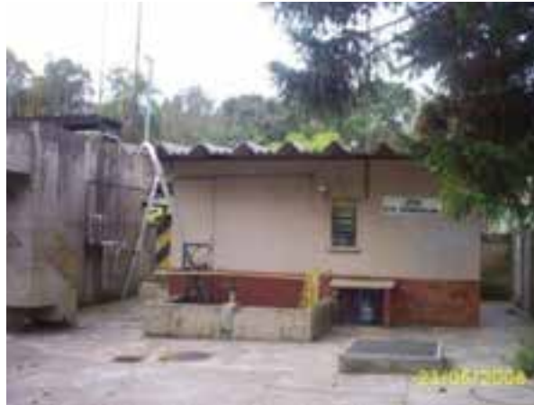
Figura 5.40 – Foto da ETE Esmeralda
