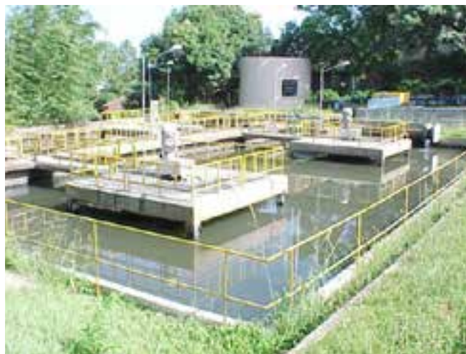
Figura 5.13 – Foto da ETE Arvoredo
