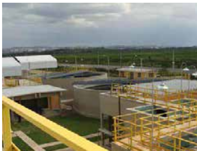
Figura 5.15 – Foto da ETE Sarandi
