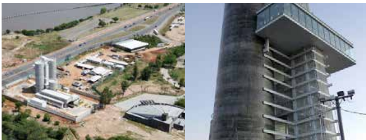
Figura 5.37 – Vista aérea da EBE Cristal com Chaminés de Equilíbrio (detalhe)
