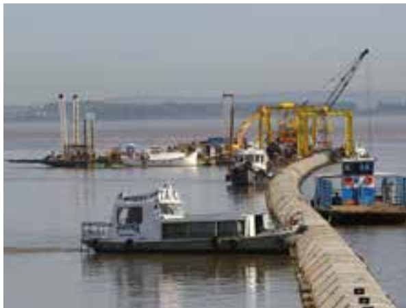
Figura 5.38 – Implantação do Emissário Subaquático no Guaíba
