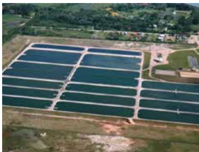
Figura 5.76 – ETE Belém Novo
