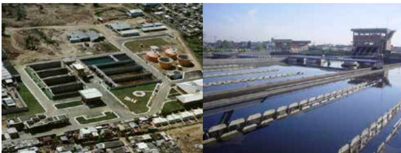
Figura 5.27 – ETE São João/Navegantes
